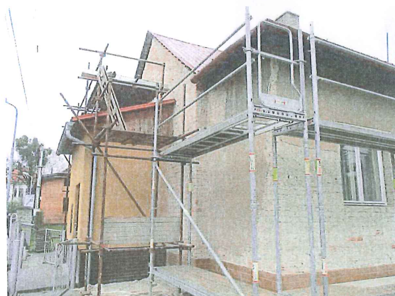
Odstranění nesoudržných omítek
