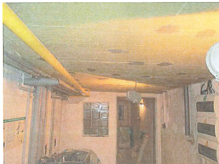
Lepení izolantu z MW na strop 1.PP
